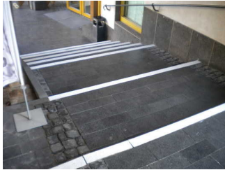
Treppe in den Innenhof
