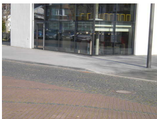
Weg vom Parkplatz zum Nebeneingang
