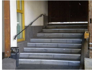
Treppe in den Innenhof
